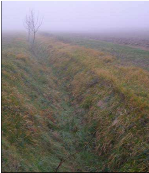
1- Section amont du ruisseau
