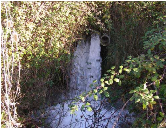
3- Rejet d'exhaure de la carrière : sortie de pompe
